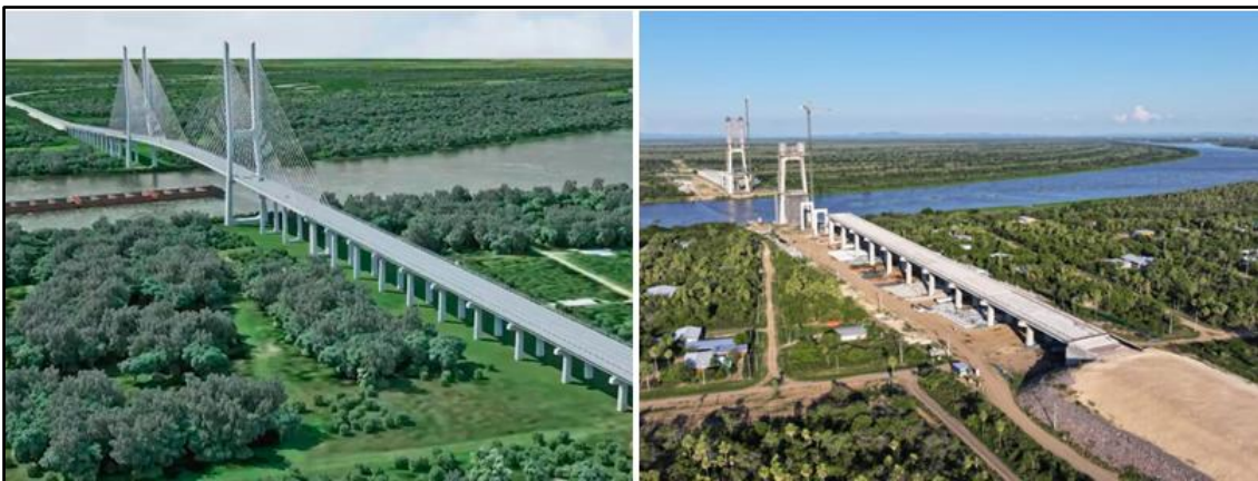
Figura 7: Ponte Binacional sobre o Rio Paraguai na fronteira Brasil x Paraguai (projeção futura x situação em março de 2025)
