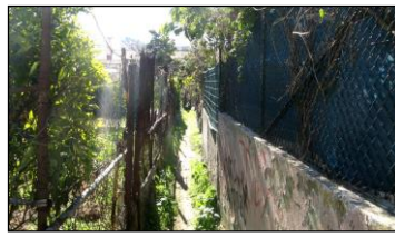
Figura 3 – Passagem pedonal estreita e de difícil atravessamento (célula 1)
