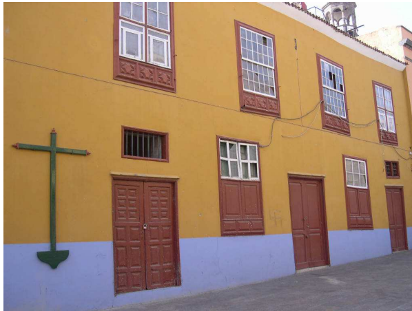
Figura 3. Rehabilitación de fachadas
