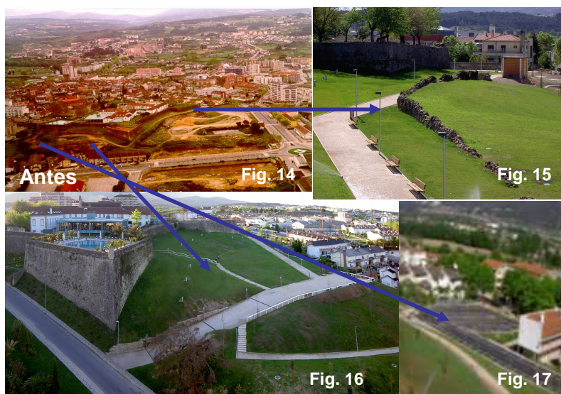
Figuras 14, 15, 16 e 17: Arranjo urbanístico da envolvente do Forte de S. Francisco (obra já concluída) Fonte: ChavesPolis, S.A.
