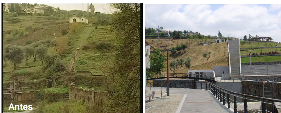
Figuras 3 e 4 - Encosta da capela do Senhor da Piedade (antes e depois da intervenção Polis) Fonte: BragançaPolis, S.A
